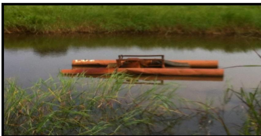
**Figura 31-** Bomba flight KSB submersível na caixa 3. Fonte: Autor.
